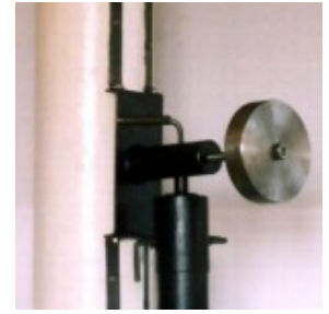
Крепление трубы к монтажке
