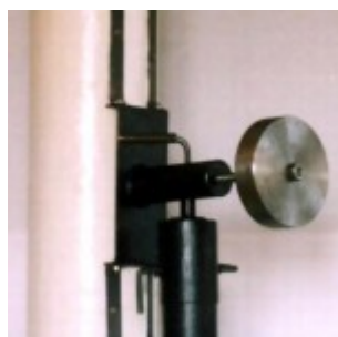
Крепление трубы к монтажке
