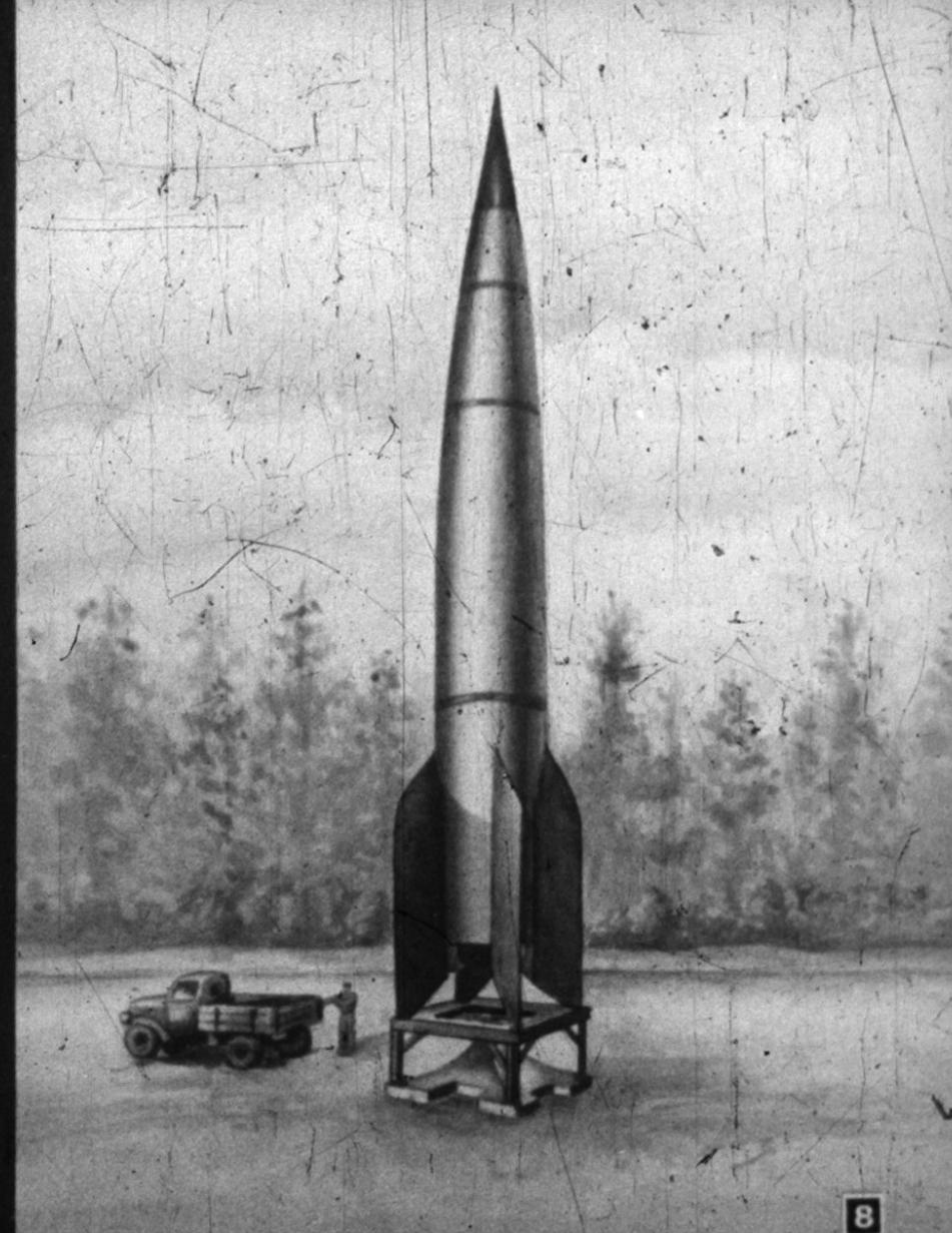
Так устроена современная ракета, работающая на жидким топливом. В головной части размещаются приборы и аппаратура управления, в средней – топливные баки, в хвостовой – двигатель и приспособления для подачи топлива. На пути газового потока помещены рули.
